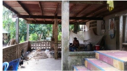
↑ ก่อนดำเนินการปรับปรุงซ่อมแซม
