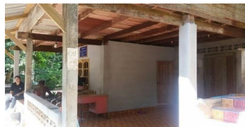
↑ ดำเนินการปรับปรุงซ่อมแซมเรียบร้อย
