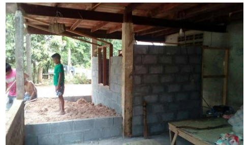
↑ ระหว่างดำเนินการปรับปรุงซ่อมแซม
